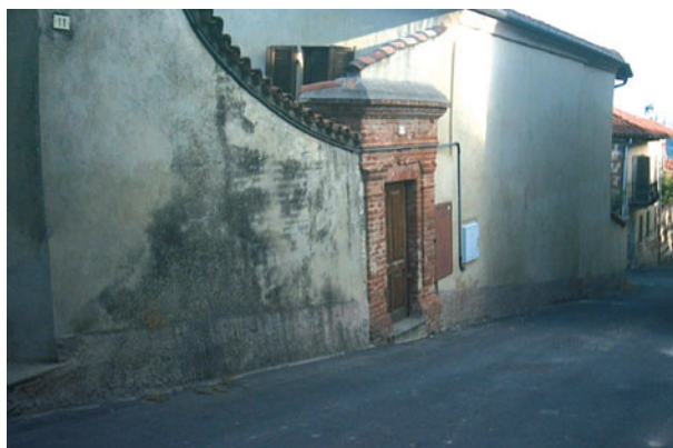
Pino d'Asti Intonacatura e portoncino pedonale con struttura di ingresso. Tipico andamento curvo per raccordo con la facciata
