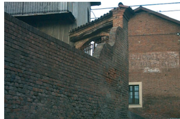
Cortanze Muro in mattoni a vista, restaurato, con tipico andamento di raccordo con la struttura di ingresso carraio.
