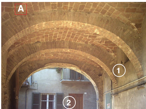
Androne su strada (Aramengo)
