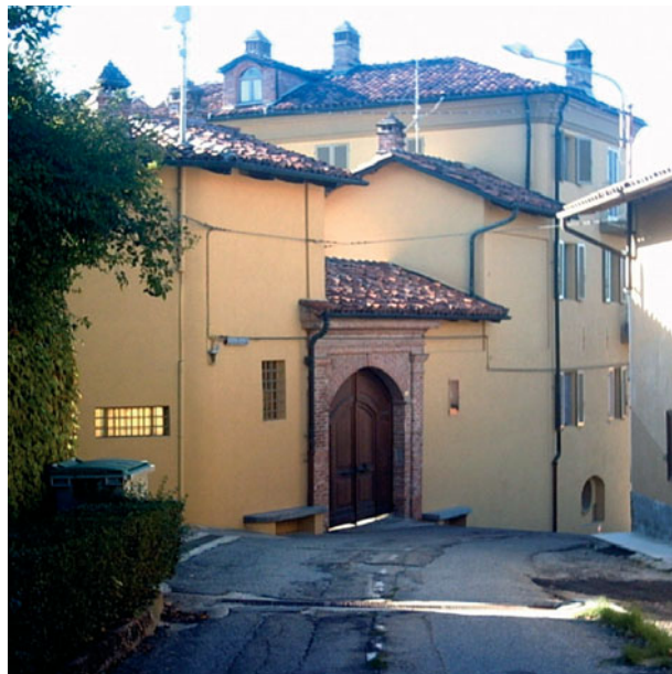
Restauro di edificio civile d'epoca Berzano San Pietro
