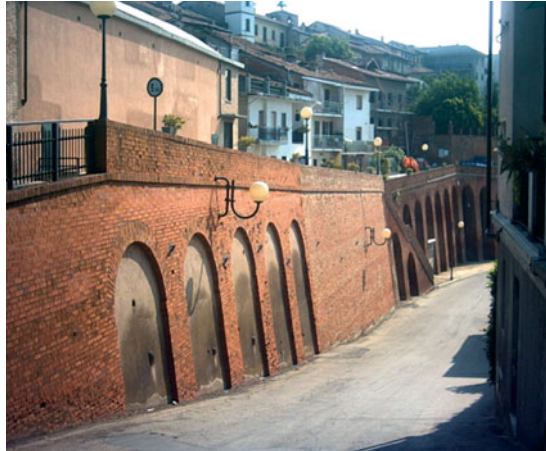
La strada sottomuro di Montechiaro
