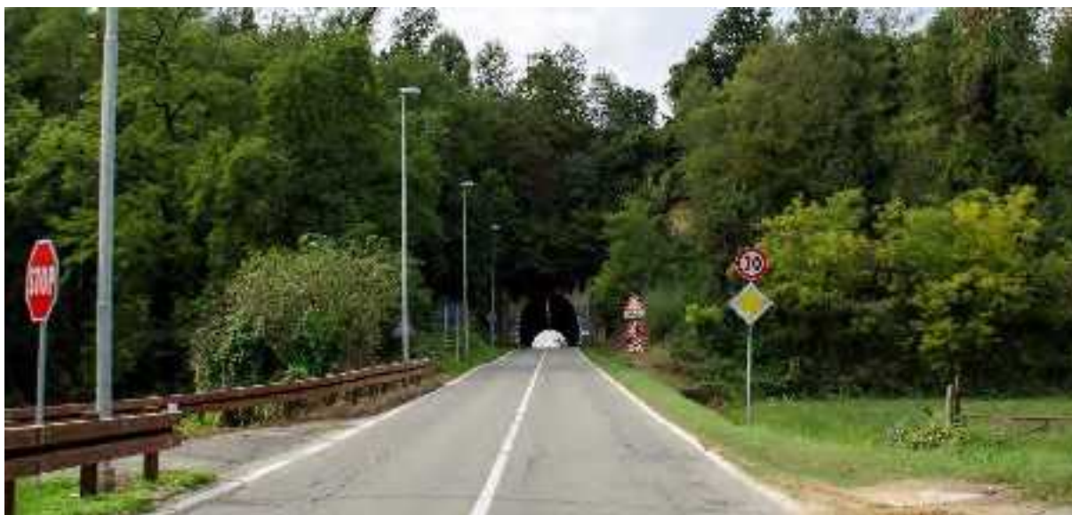
Ingresso alla galleria "Sarino", verso Castelnuovo Don Bosco
