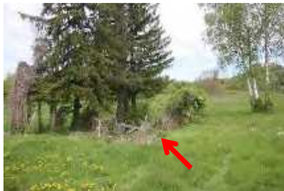
Moncucco, recinzione "naturalizzata" in fase di crollo
