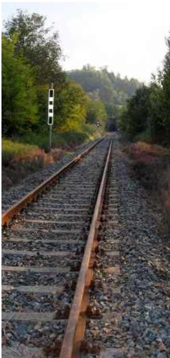
Ingresso alla galleria in direzione di Montechiaro d'Asti
