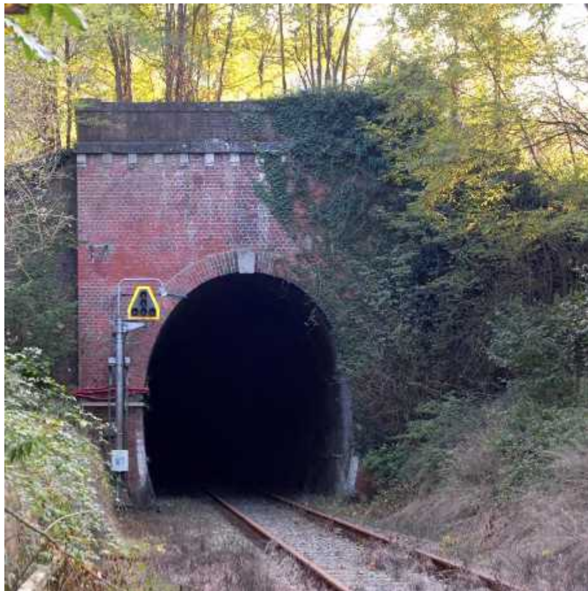
Ingresso alla galleria in direzione di Montechiaro d'Asti
