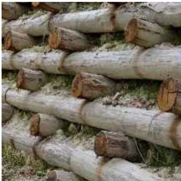
Dettaglio di una palificata doppia
