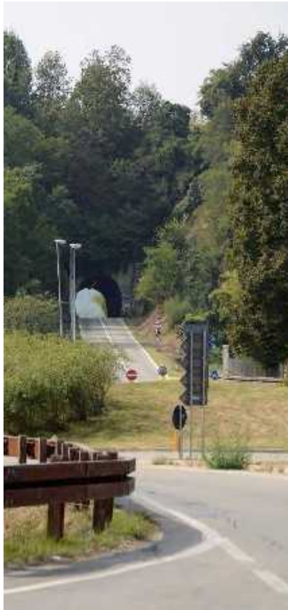
Ingresso alla galleria "Ranello", verso Castelnuovo Don Bosco
