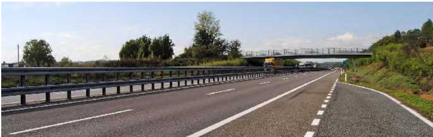
Autostrada dei Vini, con sovrappasso di strada comunale
