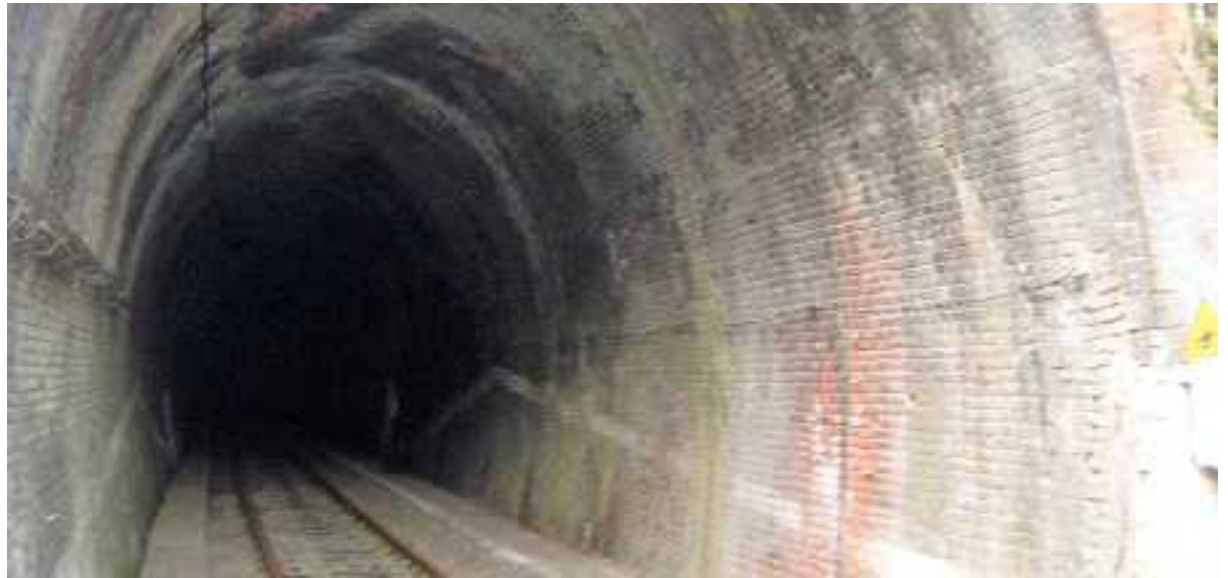
Ingresso alla galleria in direzione di Brozolo
