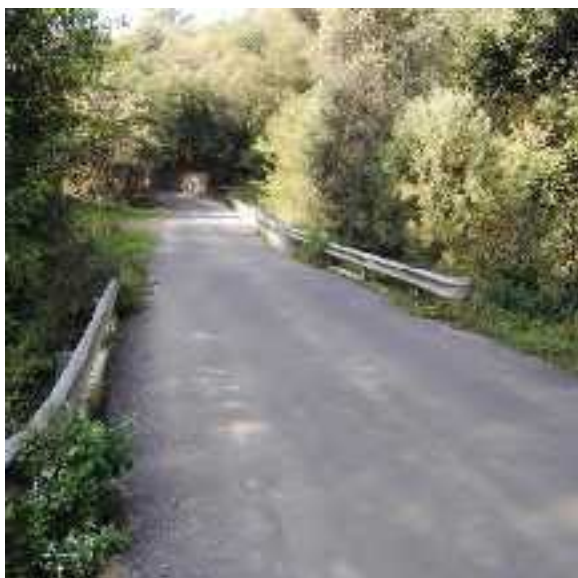
Strada comunale, nei dintorni di Valfenera
