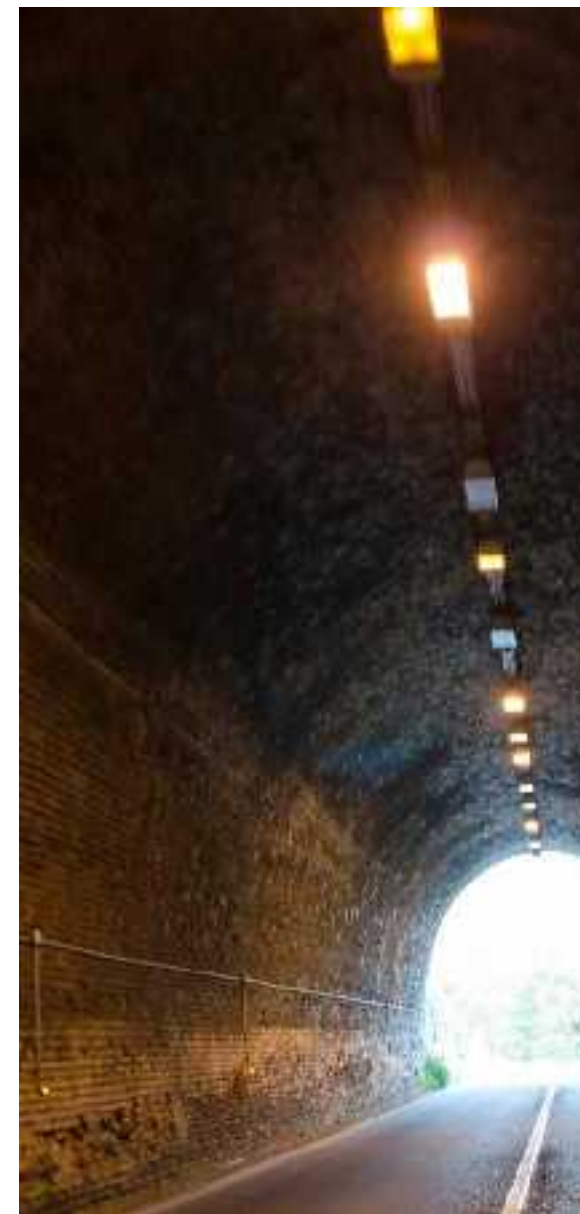
Interno della galleria "Margherita"
