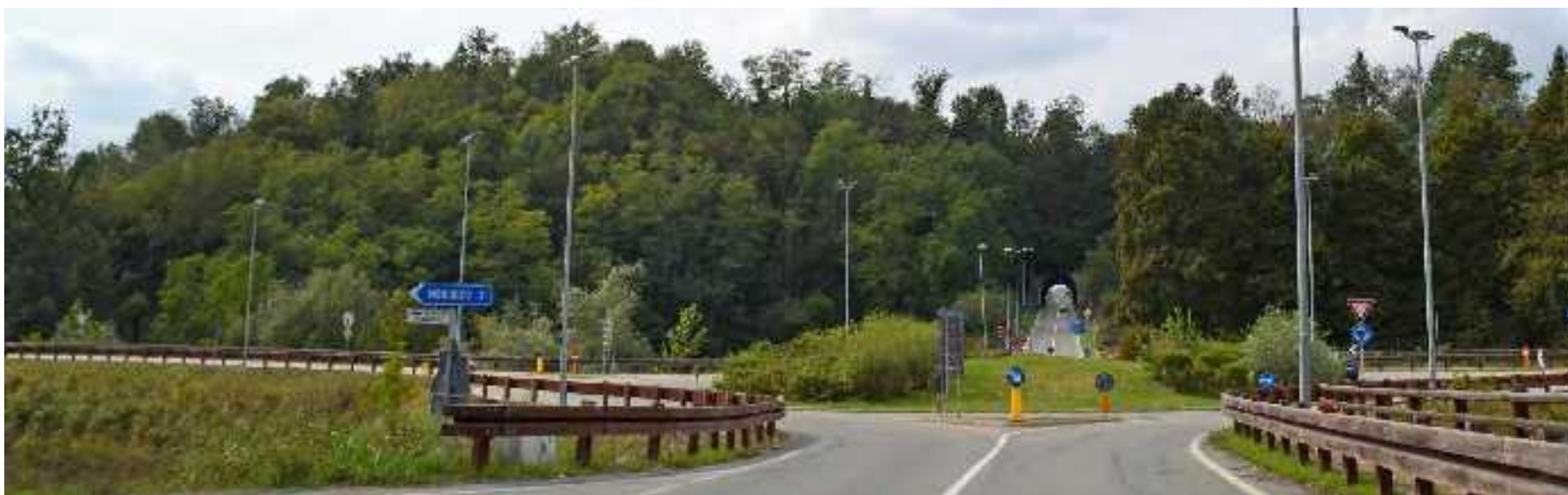
Ingresso alla galleria "Ranello", verso Castelnuovo Don Bosco
