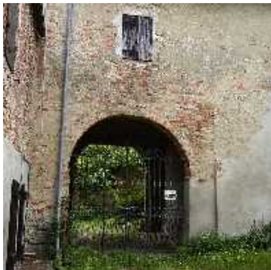
Comune di Montafia – Frazione Bagnasco
