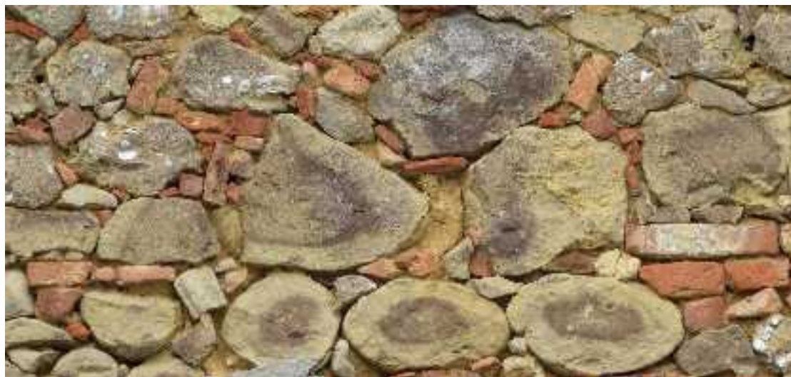
Comune di Montafia – Frazione Bagnasco
