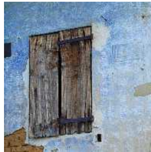
Comune di Caprilgio – Intonaco a colorazione blu del 1890
