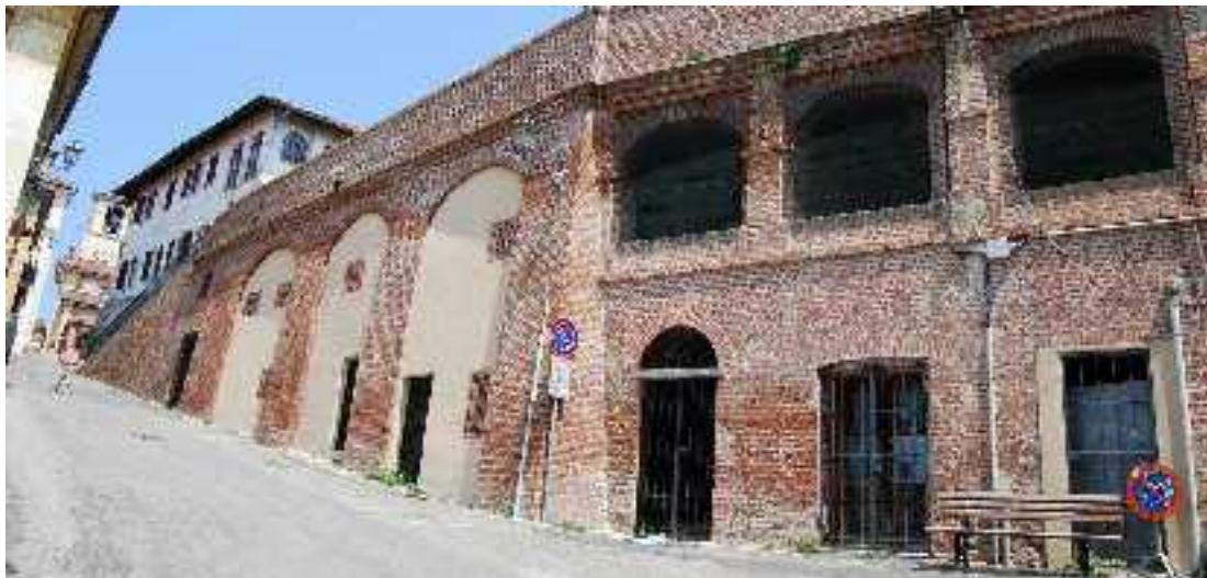
Opere di sostegno della soprastante piazza del vecchio Municipio a Castelnuovo Don Bosco
