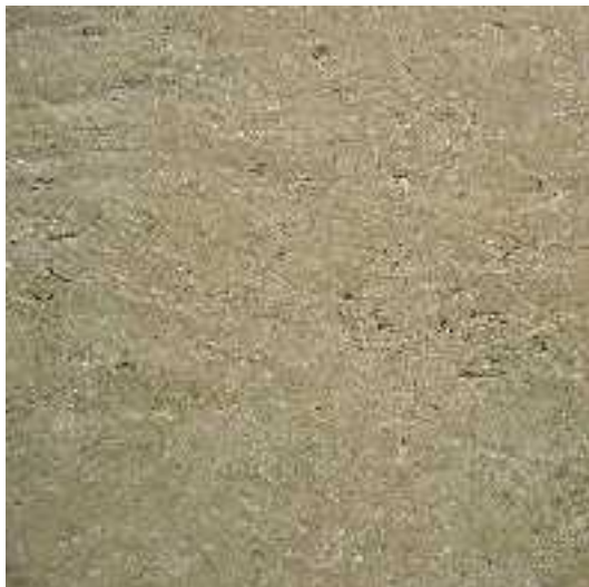
Comune di Plea – Frazione Vallunga – Intonaco con "signature"
