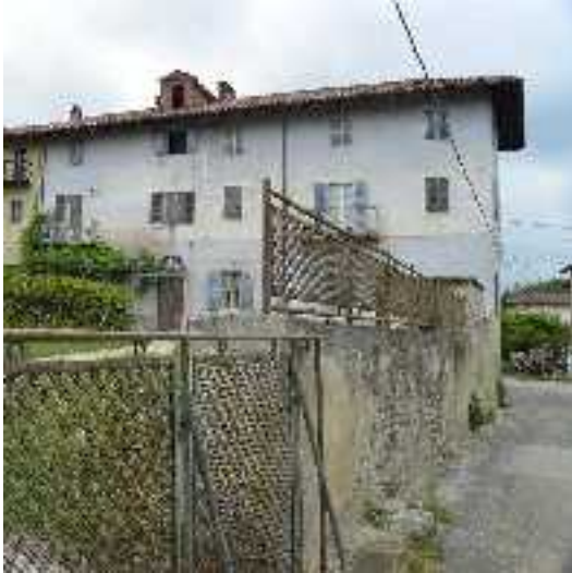
Comune di Montafia – Frazione Bagnasco
