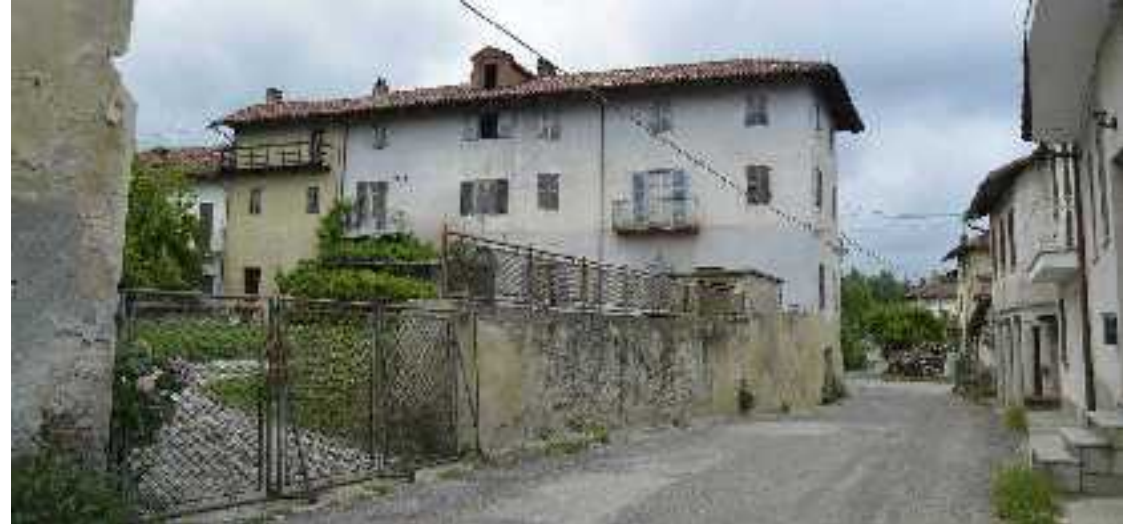
Comune di Montafia – Frazione Bagnasco
