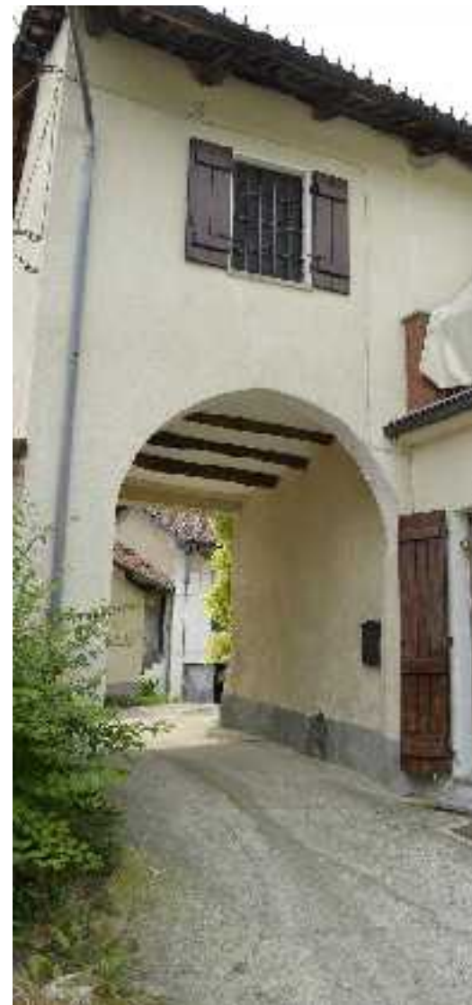
Comune di Montafia – Frazione Bagnasco
