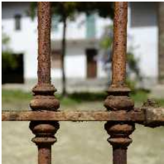
Comune di Cortazzoze – Particolare di cancello carraio
