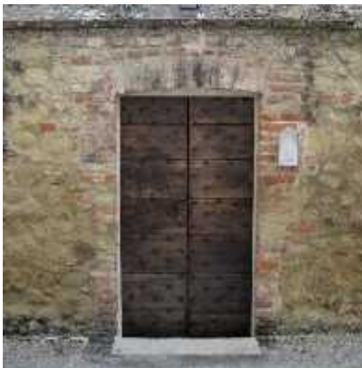
Comune di Montafia – Frazione Bagnasco
