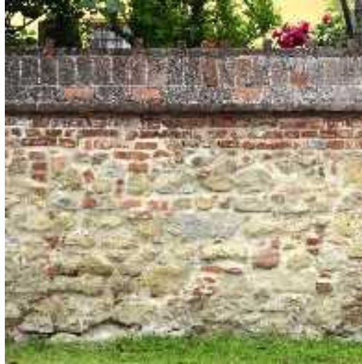
Comune di Montafia – Frazione Bagnasco
