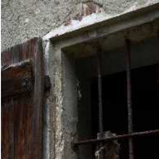
Riquadratura della finestra con gesso
