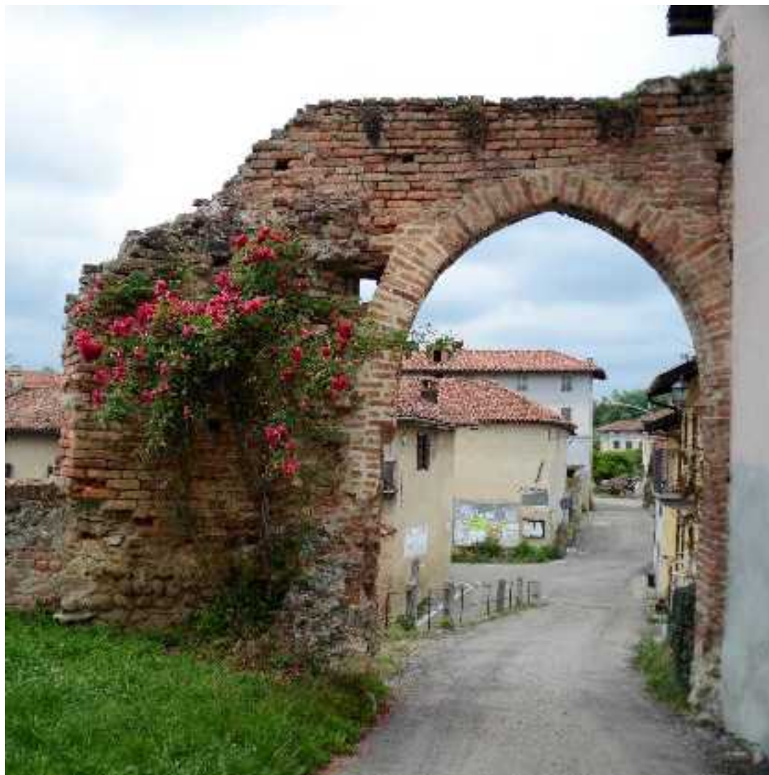
Comune di Montafia, frazione Bagnasco
