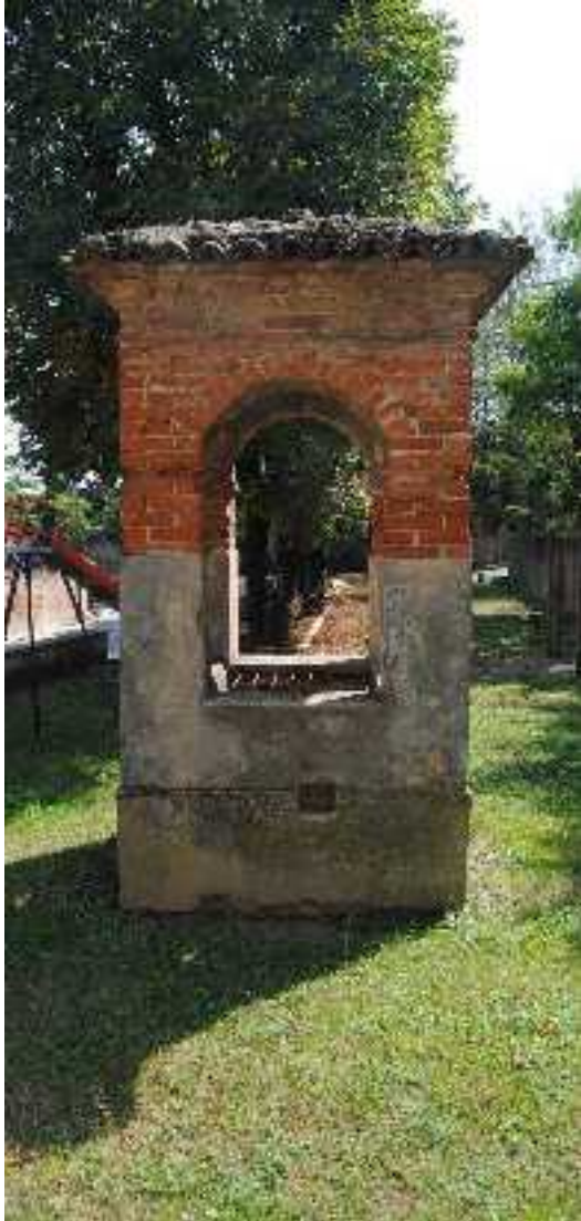
Pozzo in muratura ad Altavilla Monferrato
